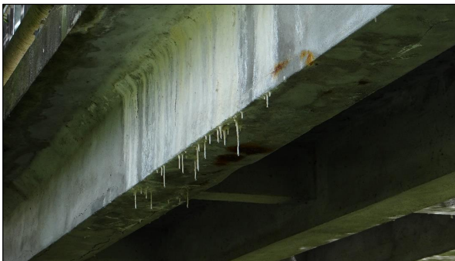
Obr. 37 Stopy po zatečení a krápníky na levém krajním trámu
