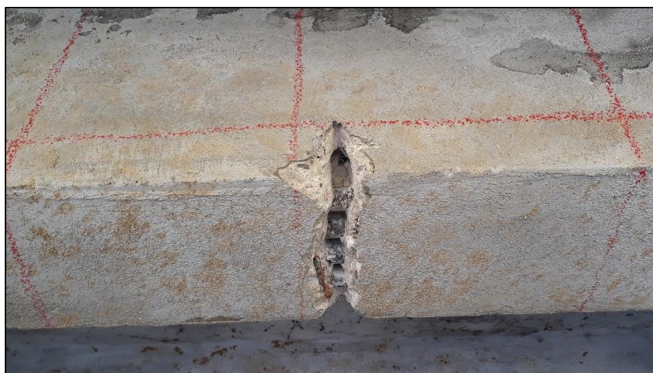
Obr. 21 Sekaná sonda S1 (hl. trám)
