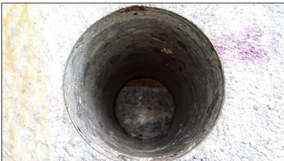
Obr. 18 Pohled do vrtu V3 (OP1)
