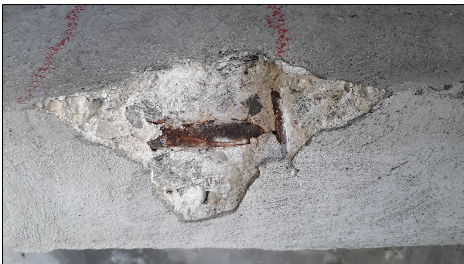
Obr. 25 Sekaná sonda S2 (příčník) – detail
