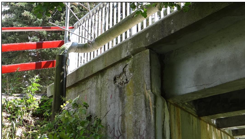
Obr. 36 Opadu betonu na OP2 a stopy po zatékání
