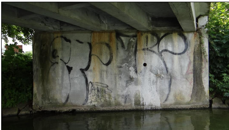
Obr. 17 Fotodokumentace z odebrání jádrových vývrtů z OP1 – místo odběru vrtu V3
