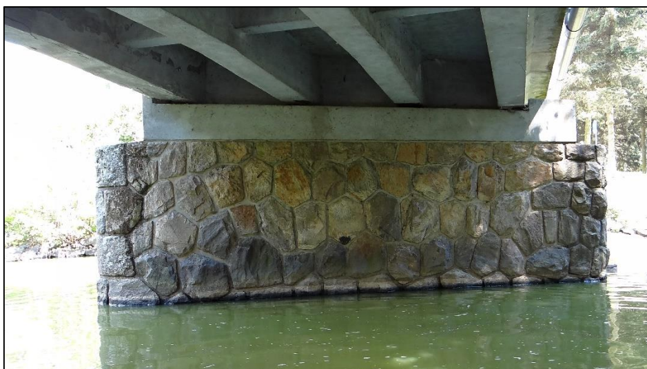
Obr. 5 Pohled na střední mezilehlou opěru s kameným obkladem
