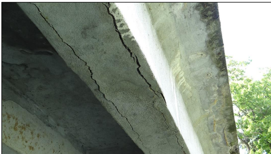
Obr. 34 Trhliny na spodním líci levého krajního trámu
