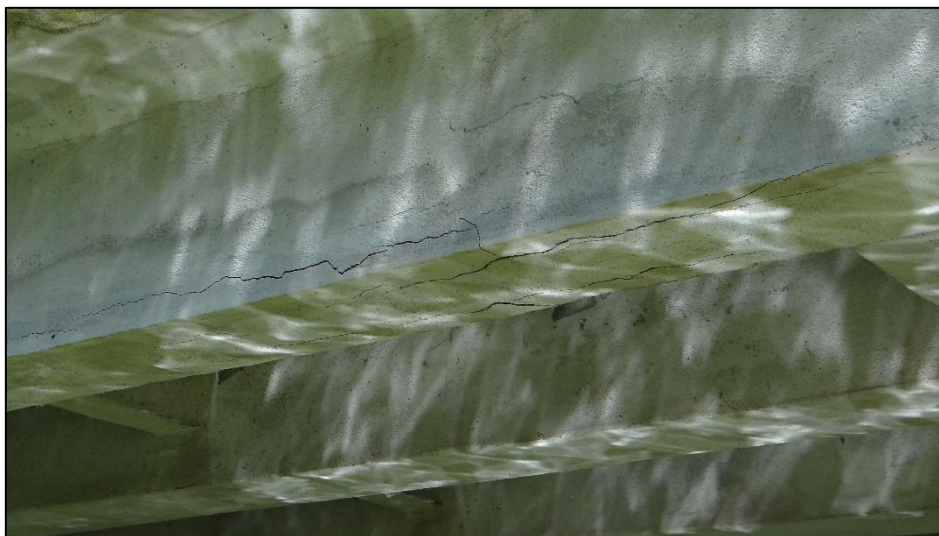
Obr. 35 Pohled na síť trhlin v nekvalitně provedené sanační vrstvě
