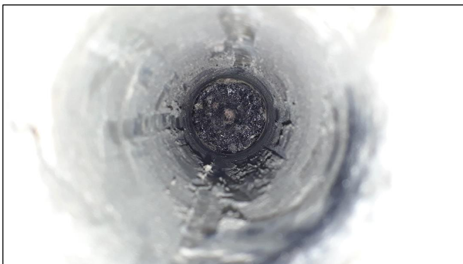
Obr. 31 Vrtaná sonda M1 – detail (hydroizolace z dehtové lepenky)
