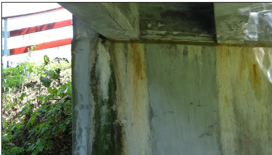
Obr. 38 Výluhy a stopy po zatékání jsou značné i na spodní stavbě (na fotce OP2)
