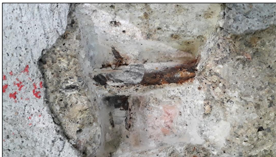
Obr. 28 Sekaná sonda S3 (mostovková deska) - detail
