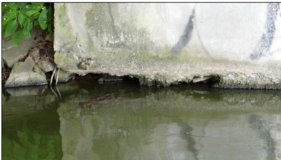
Obr. 40 Opěra OP1 – pohled na kavernu na styku opěry s vodní hladinou (hloubka kaverny cca 300 mm)
