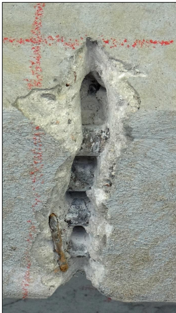
Obr. 22 Sekaná sonda S1 – detail (hl. trám)
