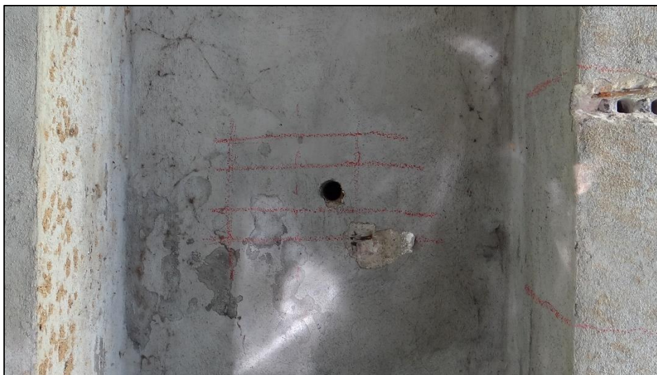
Obr. 30 Vrtaná sonda M1 (mostovková deska)
