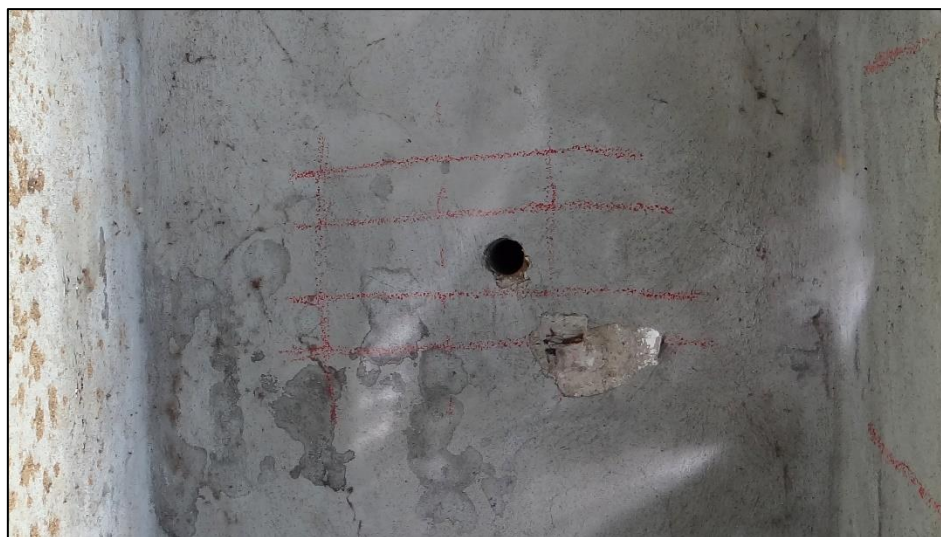
Obr. 27 Sekaná sonda S3 (mostovková deska)
