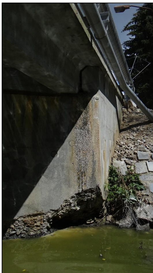
Obr. 41 Opěra OP2 – pohled na kavernu (hloubka kaverny cca 600 mm)
