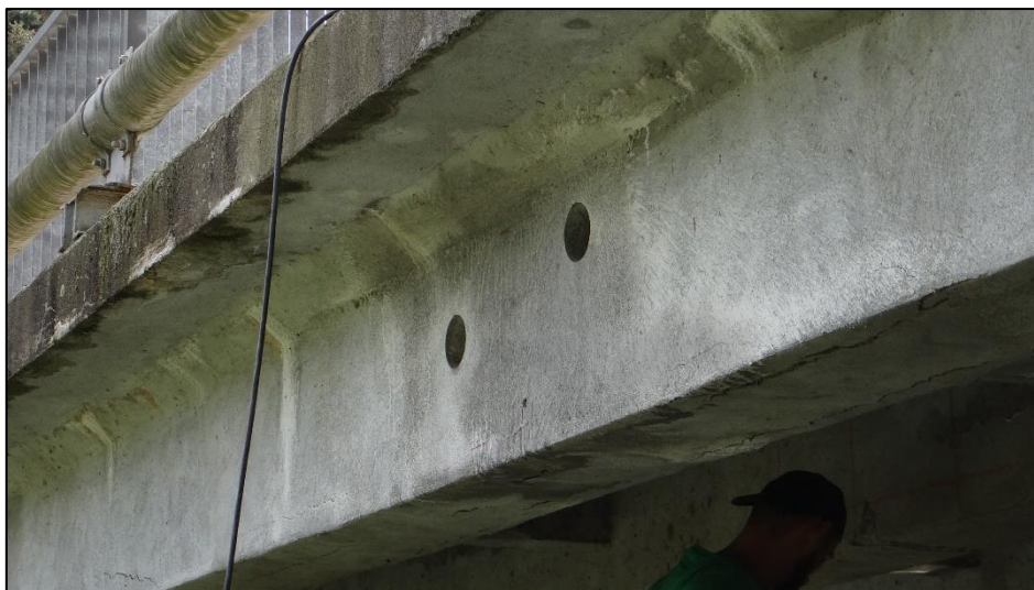
Obr. 16 Fotodokumentace z odebrání jádrových vývrtů z levého trámu – vrty V1, V2
