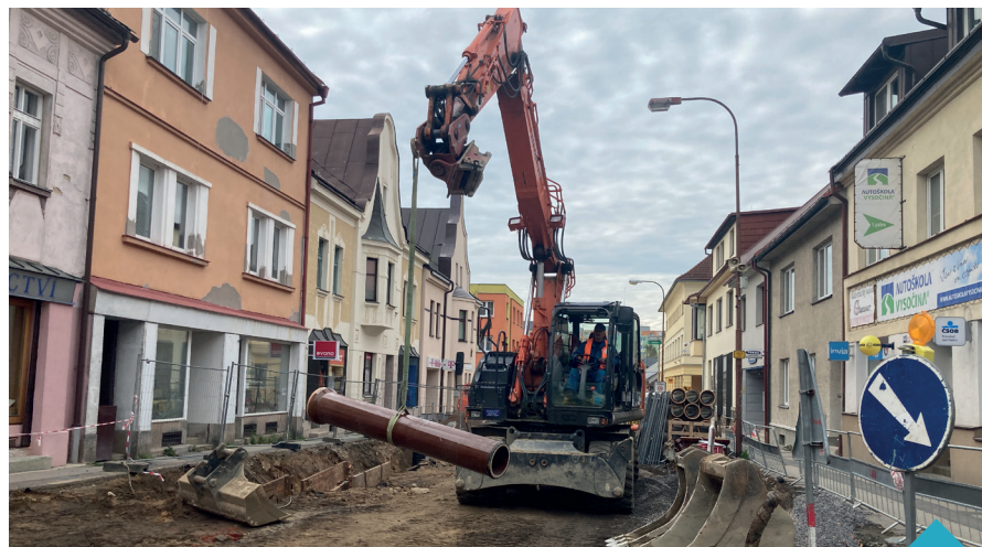
Pokládání kanalizace na Nádražní ulici
