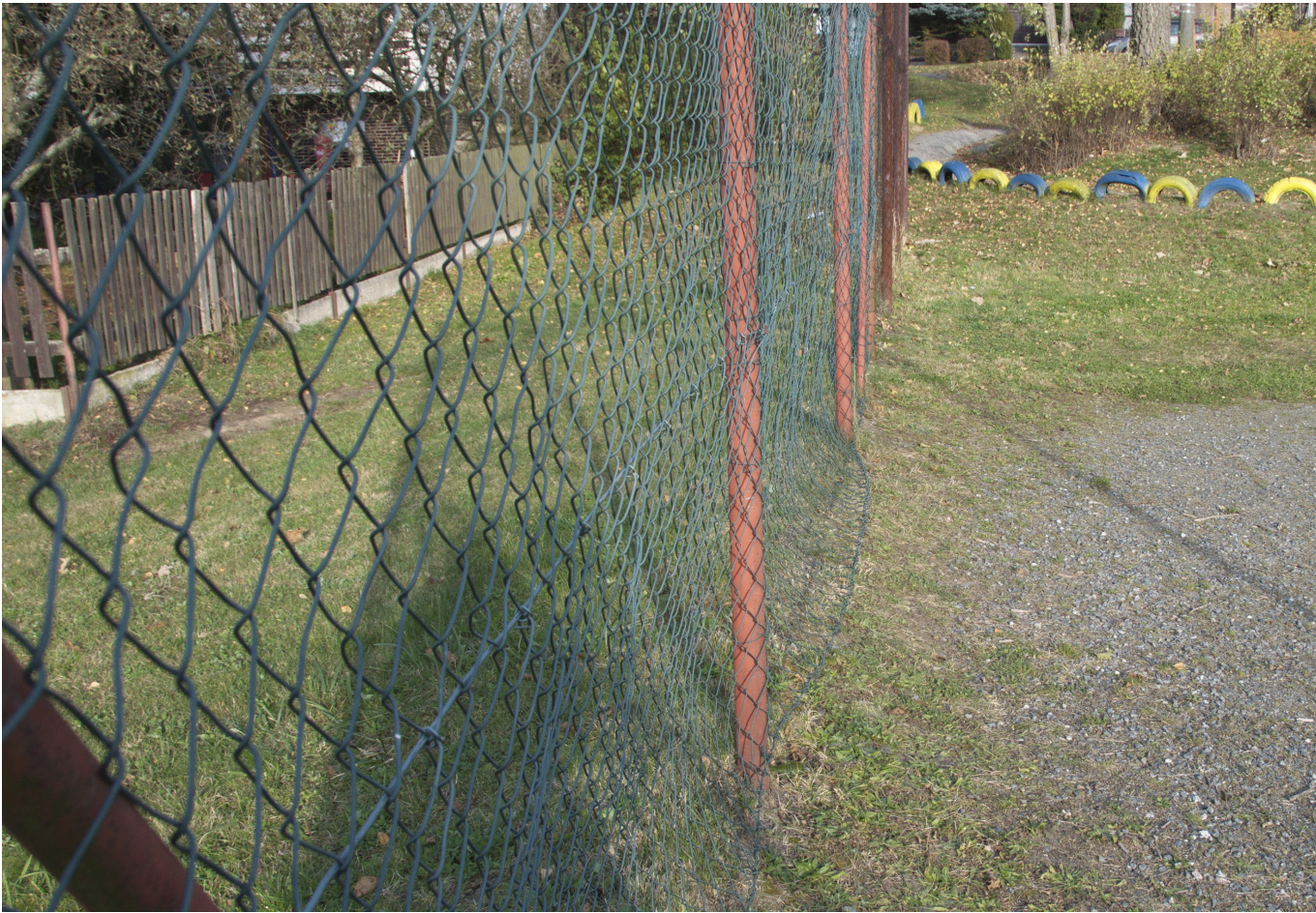
STÁVAJÍCÍ OPLOCENÍ K DEMOLICI
