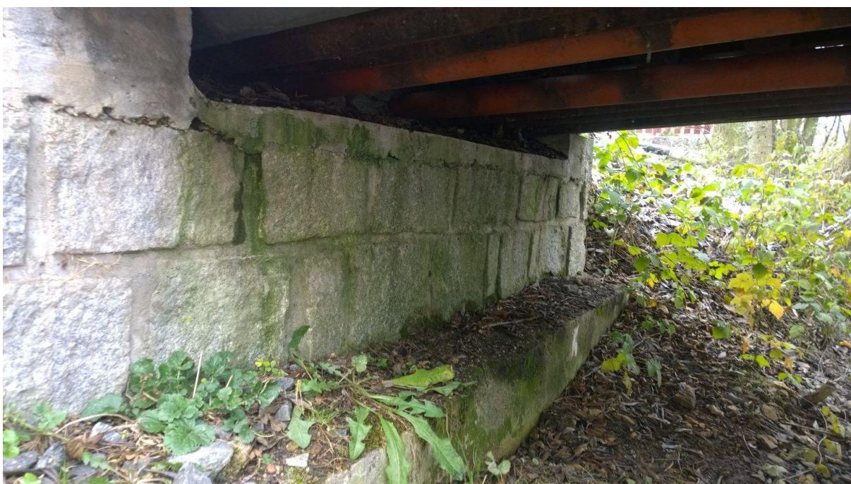
❑ obr. 4 - detail uložení na krajní podpěru
