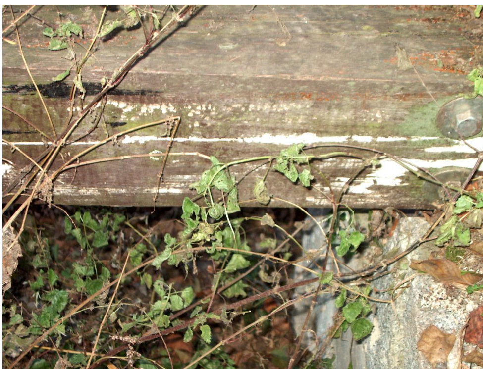
❑ obr. 6 - podhled na prohnílý konec fošny
