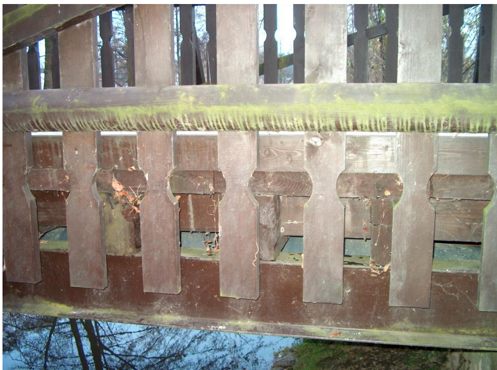
❑ obr. 7 - pohled na zábradlí lávky, povrch od řas a sinic
