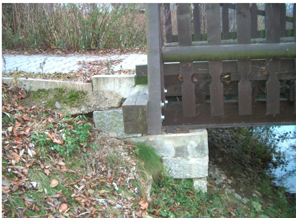
❑ obr. 4 - detail uložení na krajní podpěru, prosedlé předmostí
