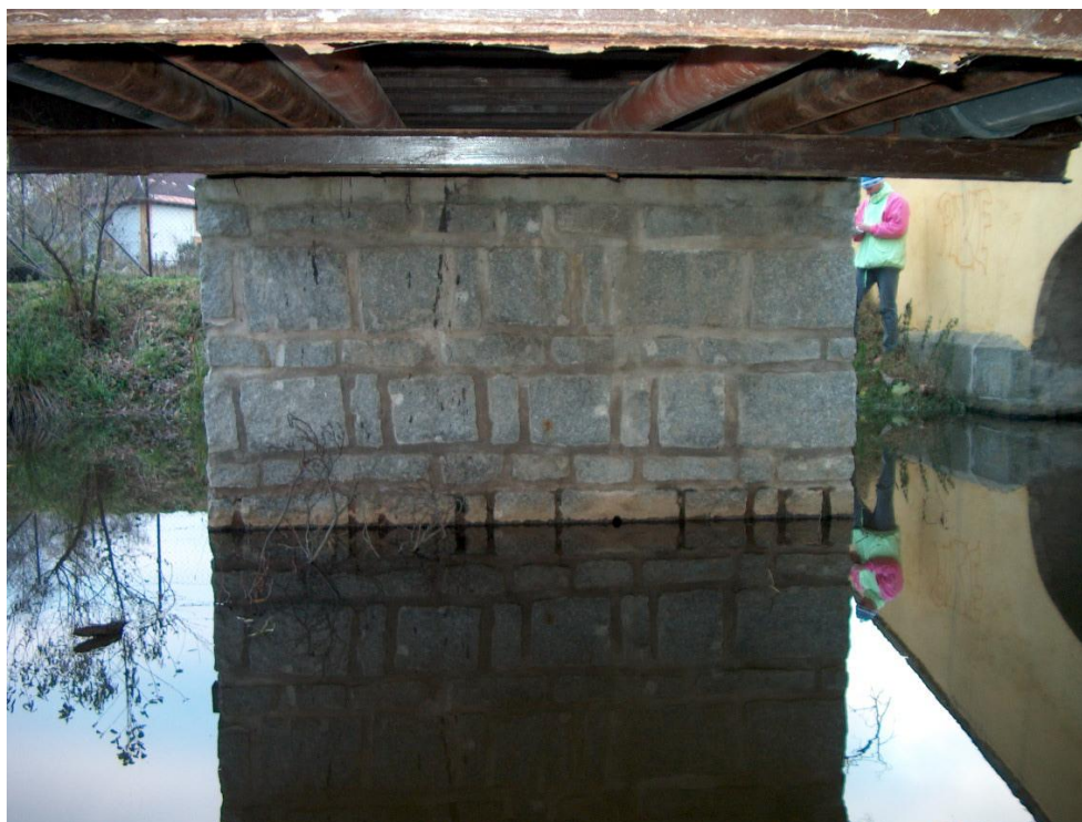
❑ obr. 8 - podhled lávky, odlupující se nátěr OK, uložení inženýrských sítí
